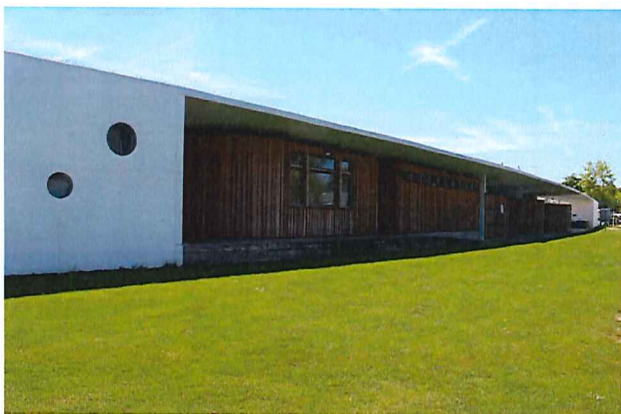
Vues extérieures état existant
