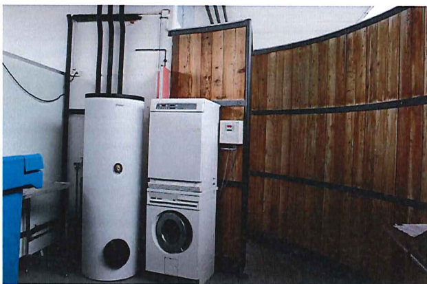
Vues intérieures état existant
